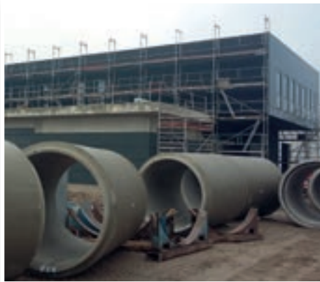
Chantier du champ captant
